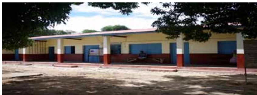
Le Centre de Santé de Base de niveau II du chef-lieu de la Commune d'Ankazomborona est indépendant de Fuelstock
